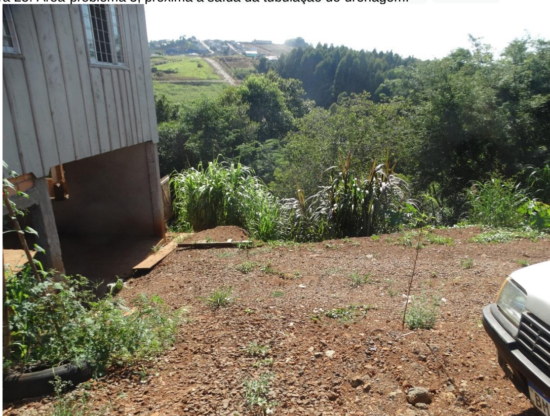
Figura 25: Área-problema 3, próxima a saída da tubulação de drenagem.
