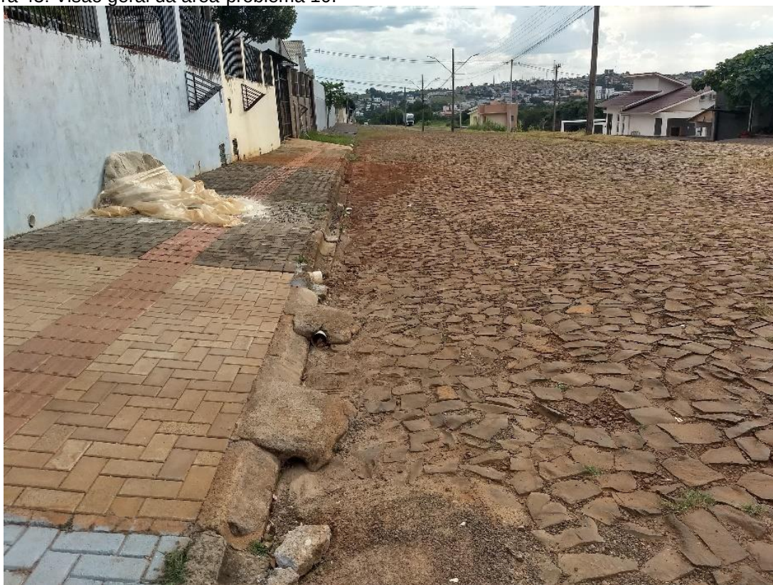
Figura 43: Visão geral da área-problema 10.
