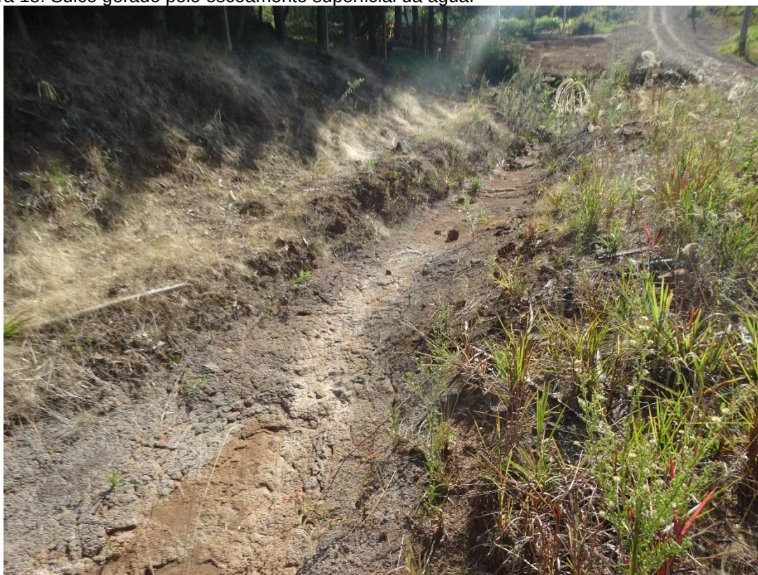
Figura 18: Sulco gerado pelo escoamento superficial da água.
